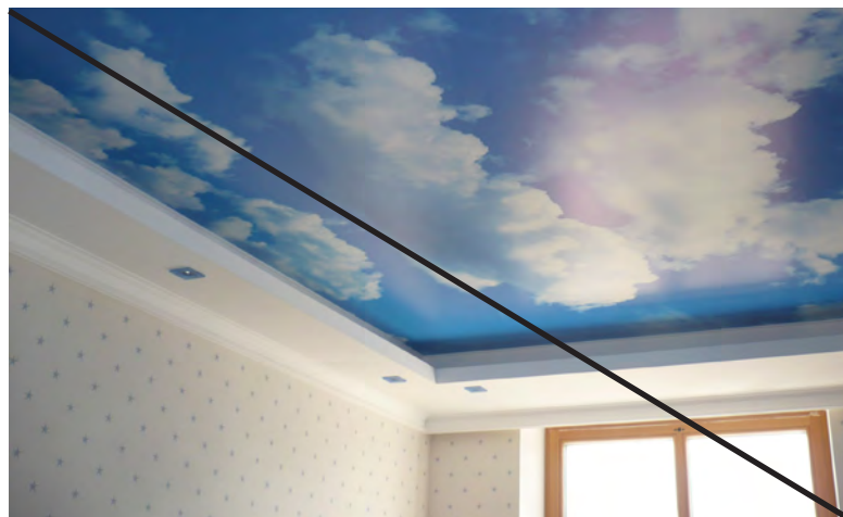
Плохо Натяжные потолки. Потолки с рисунками
